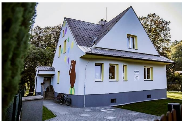
Mateřská Škola Dolní Lištná, č.p. 172, Třinec
