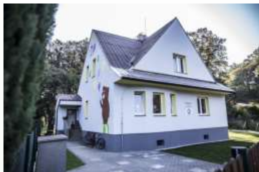
Mateřská škola Dolní Lištná č. p. 172
