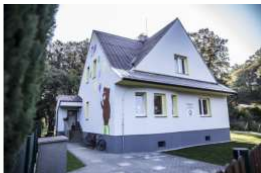
Mateřská škola Dolní Lištná č. p. 172
